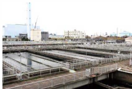
下水処理施設と監視室
