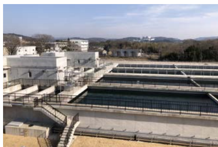
上水処理施設と監視室
